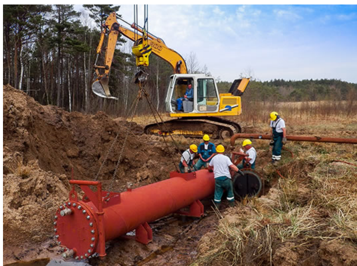
Рис. 4 – специальные камеры пуска и приема средств очистки компании «CEPS»
