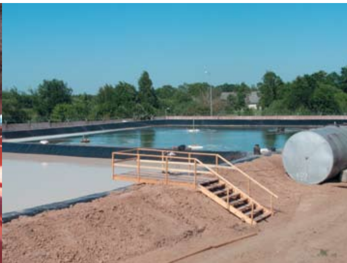
рисунок 9. Биологическая деградация нефтяных остатков, содержащихся в использованном очистном (деконтаминационном) растворе
