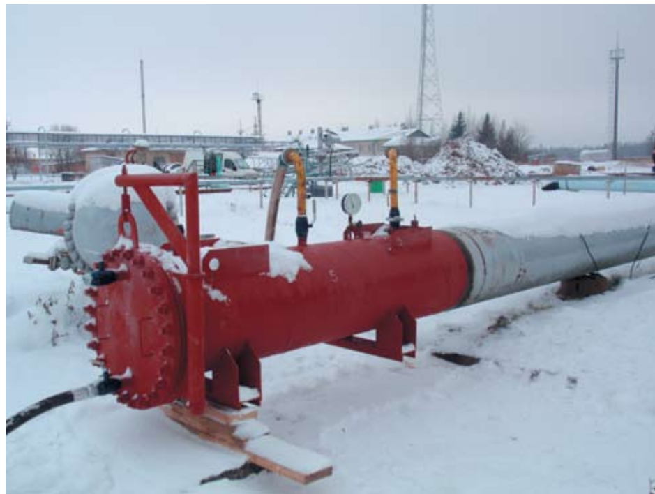
рисунок 1. Специальная камера для вытеснения нефти
