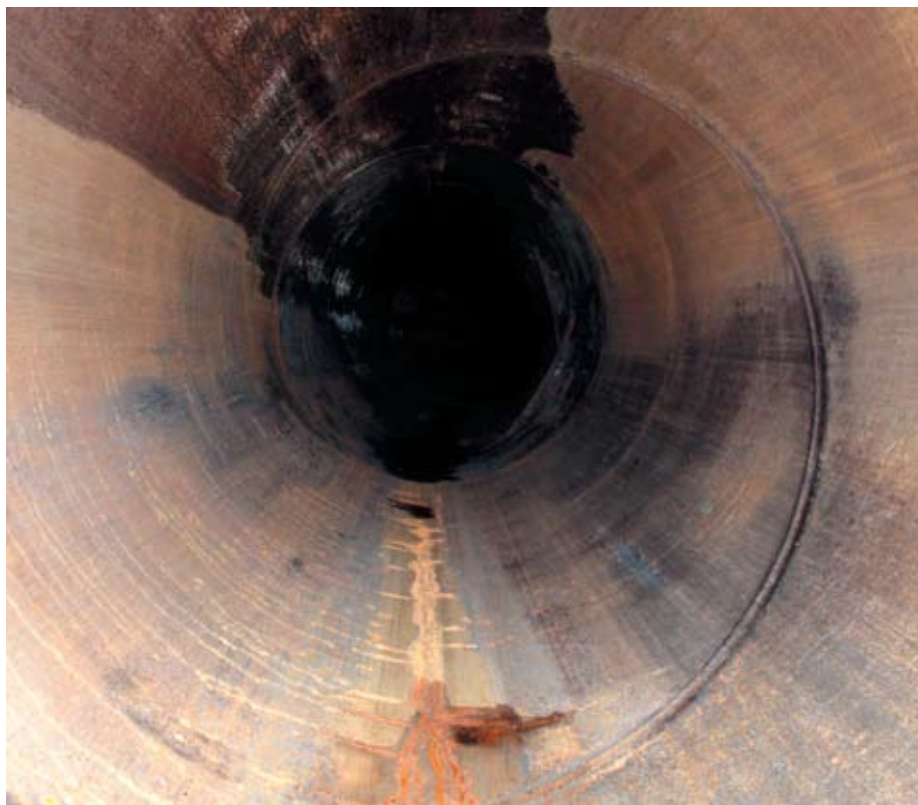
рисунок 5. Внутренняя полость нефтепровода после очистки
