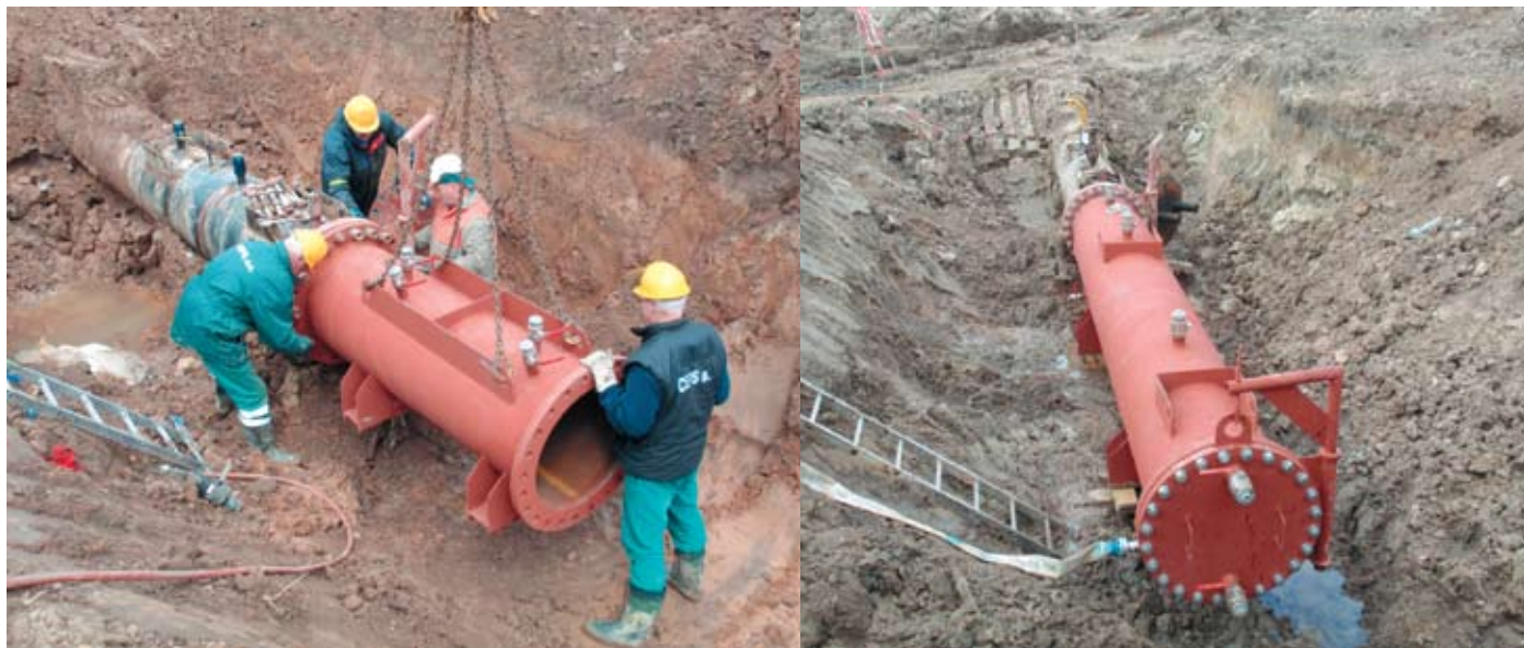
рисунок 3, 4. Монтаж специальных очистных камер
