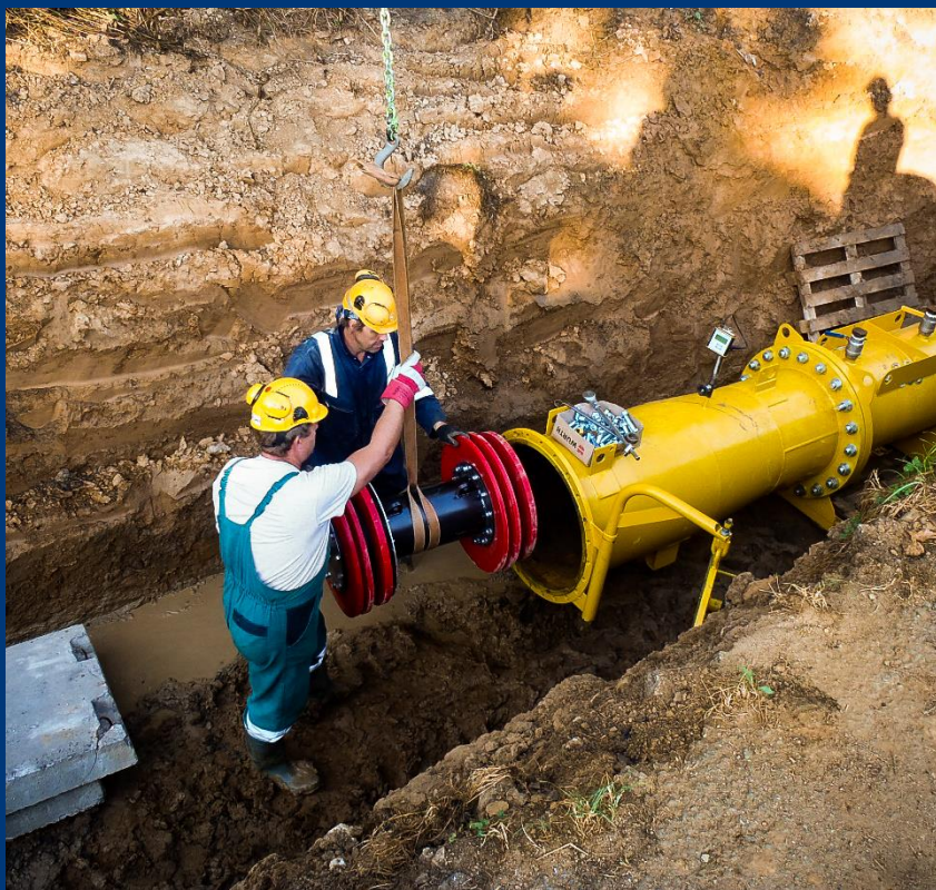
Zasouvání ježka s kalibrační deskou do startovací mobilní komory
