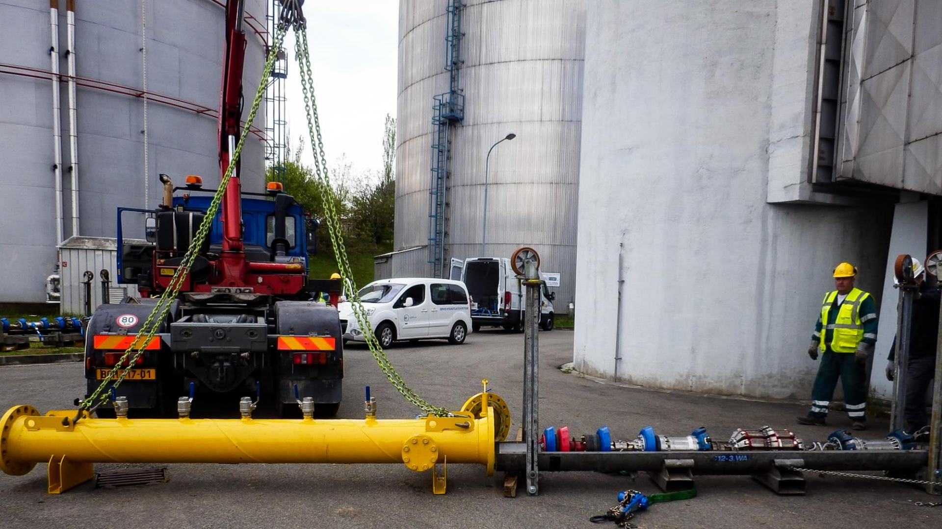
Zatahování MFL pístu do komory DN 300
