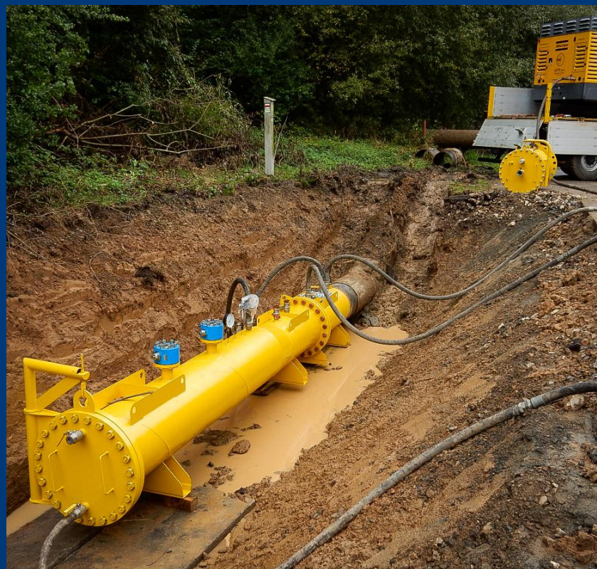
Řízené protlačování kalibračního ježka potrubím
