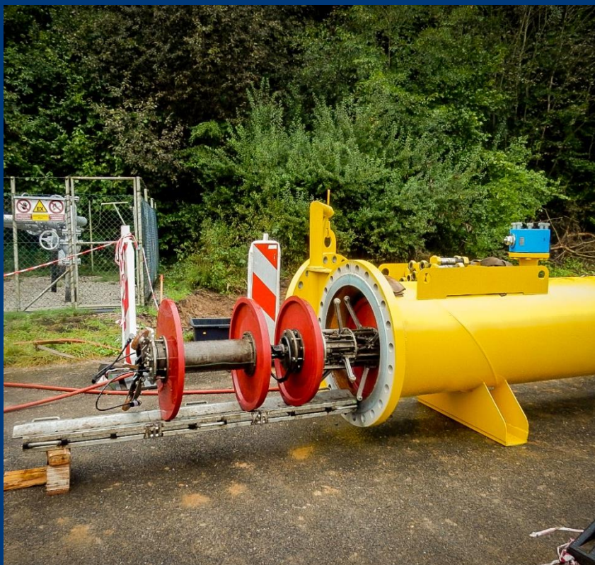
Zasouvání kalibračního ježka do startovací mobilní komory
