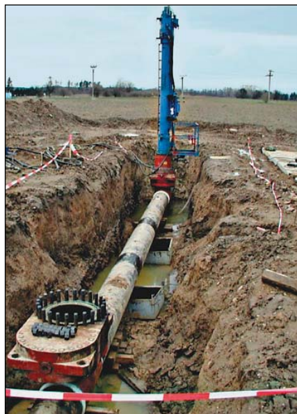
Obr. 3. Příprava na oboustranný Stopple na linii DN 500 ropovodu Družba při výřezu
