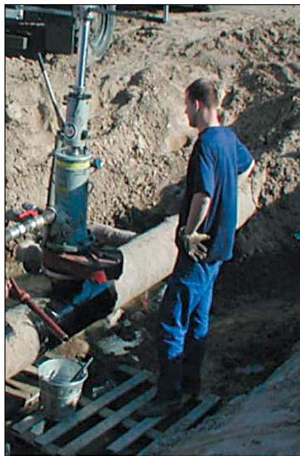
Obr. 6. Jednostranný Shortstopp na linii DN 300
