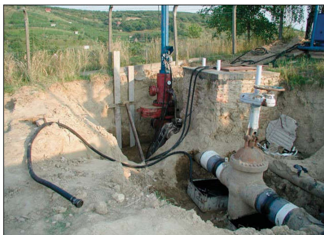
Obr. 4. Jednostranný Stopple na linii DN 500 ropovodu Družba při výřezu TU
