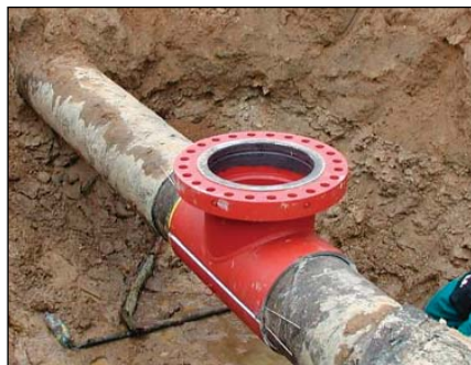
Obr. 2. Dělená plnoobkružující tvarovka
