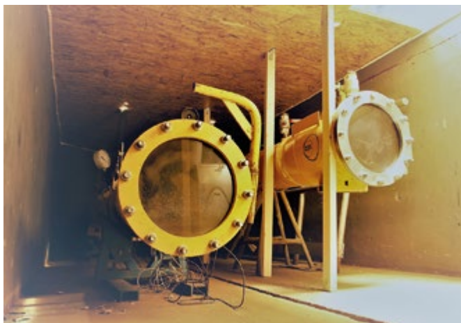
Obr. 5. Tělesa ve zkušební jámě zakryté OSB deskami Fig. 5 Pipes in the test pit covered by OSB boards
