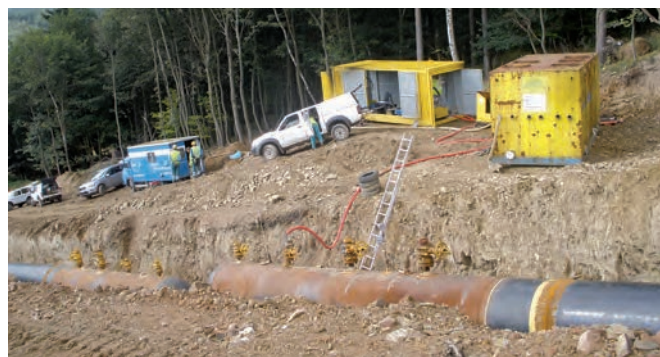
Obr. 7. Technologie připravená na stresstest v obtížném terénu, Pyšná
