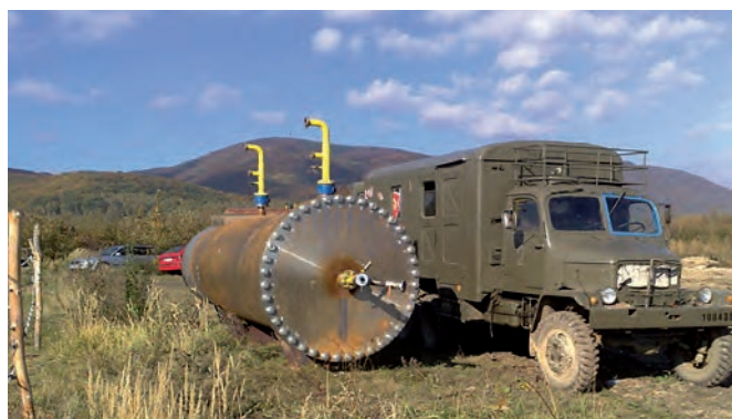
Obr. 5. Čisticí komora DN 1 400, Jirkov
