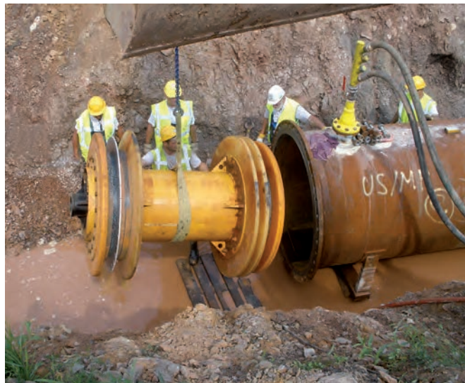
Obr. 3. Nabíjení kalibračního jeřka DN 1 400, Brandov
