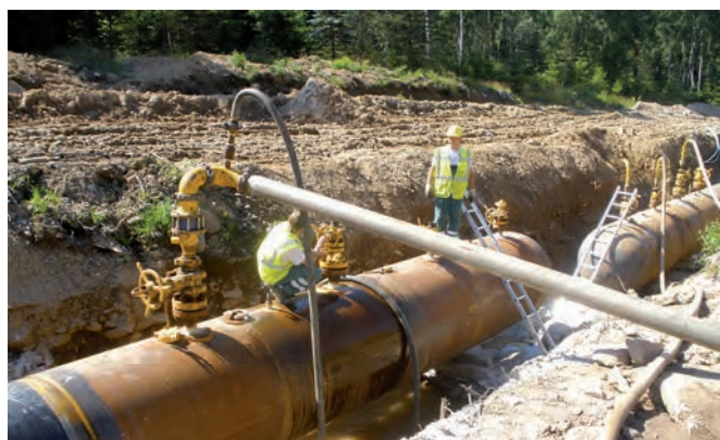
Obr. 6. Tlakovací komora, napouštění vody, Pod Vraním vrchem, Hora sv. Kateřiny
