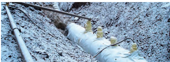
Obr. 11. Izolovaná komora DN 1 400, Jirkov
