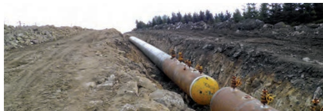
Obr. 12. Odtlakovaný plynovod DN 1 400, nejvyšší místo Gazely, Lesná
