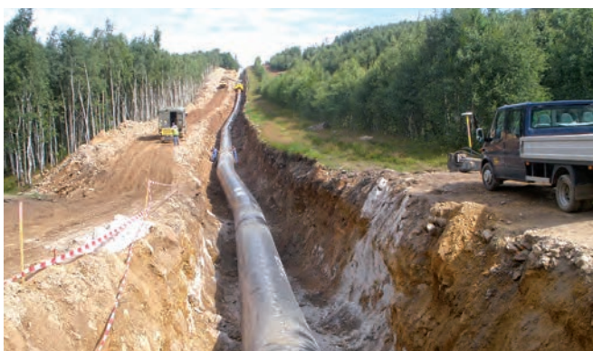
Obr. 1. Položený plynovod DN 1 400 u Pyšné
