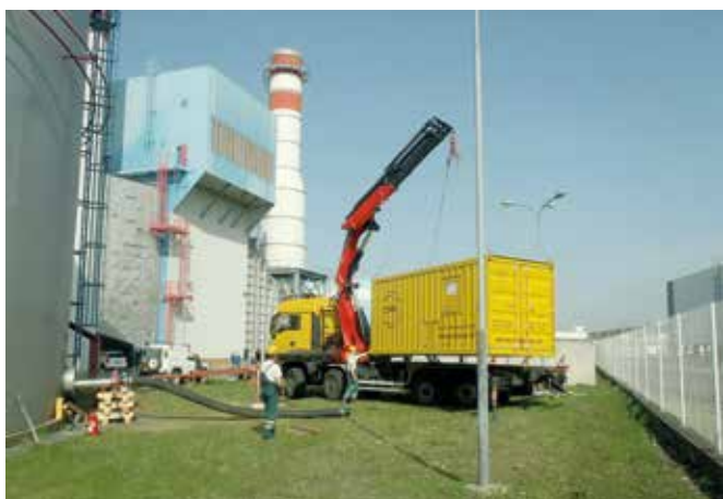
Obr. 11. Montáž sacího potrubí
