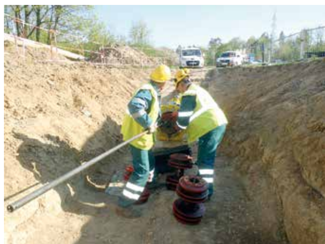
Obr. 9. Rozebírání „čisticího vlaku“
