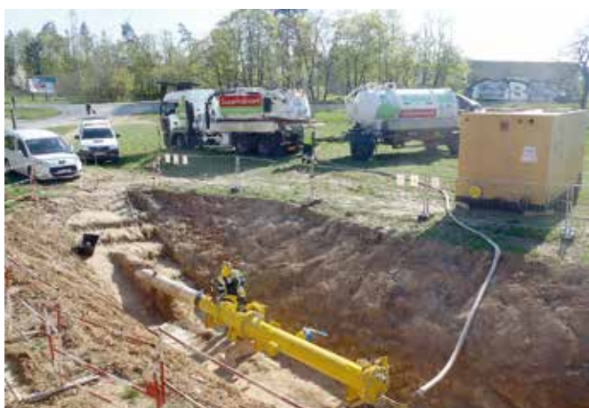
Obr. 8. Stáčení čisticího roztoku do cisterny
