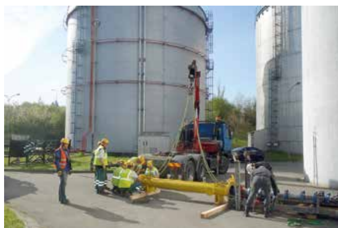
Obr. 13. „Nabíjení“ inspekčního nástroje do komory
