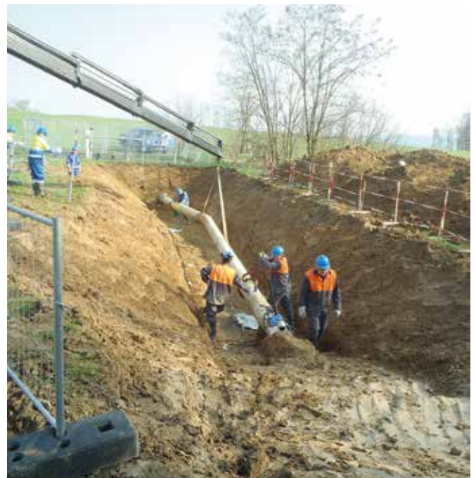
Obr. 2. Rozpojování potrubí u TU Soběšice
