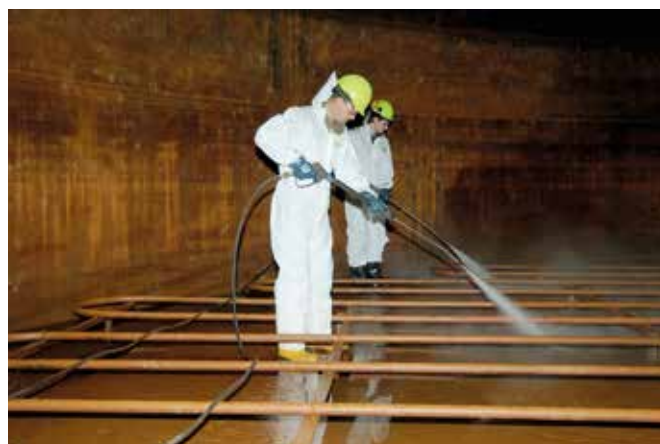
Obr. 17. Čištění vnitřku nádrže po inspekci
