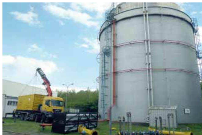
Obr. 12. Nádrž, čerpadlo a inspekční nástroje
