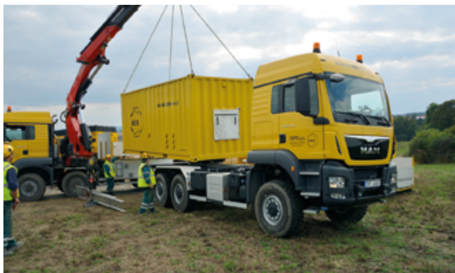
Obr. 1. Manipulace s generátorem inertizační dusíkové směsi na staveništi Fig. 1 Handling a nitrogen unit on site
