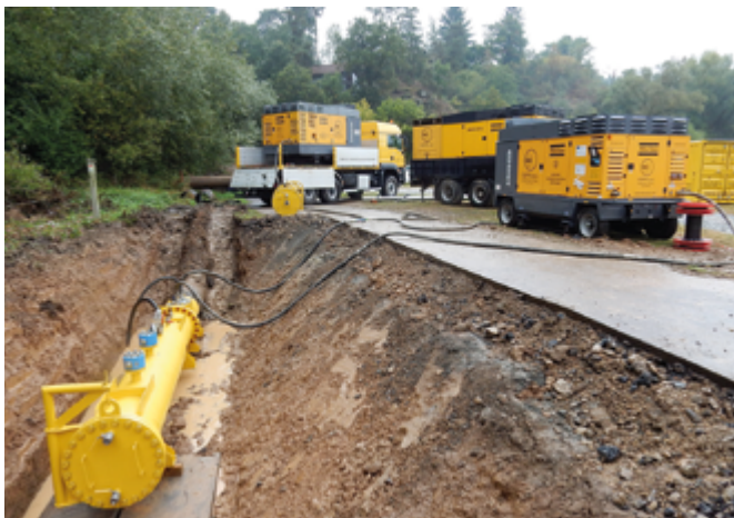
Obr. 7. Inspekce pomocí deformačního ježka Fig. 7 Inspection using an internal geometry inspection pig
