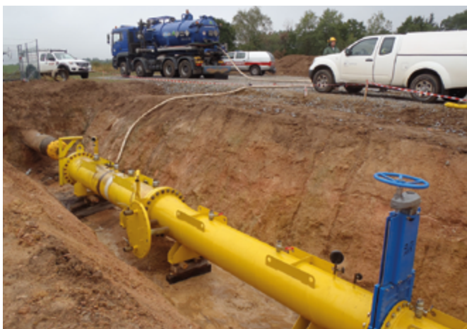
Obr. 8. Chemické čištění potrubí Fig. 8 Chemical cleaning of the pipe
