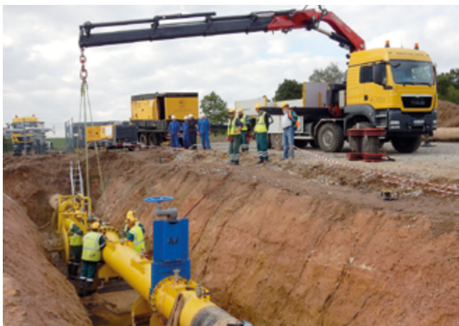
Obr. 13. Demontáž komory Fig. 13 Trap dismantling
