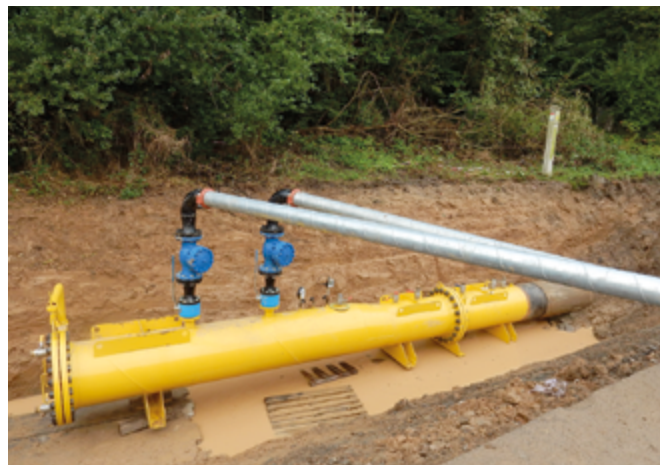
Obr. 10. Inspekční komora Fig. 10 Inspection trap
