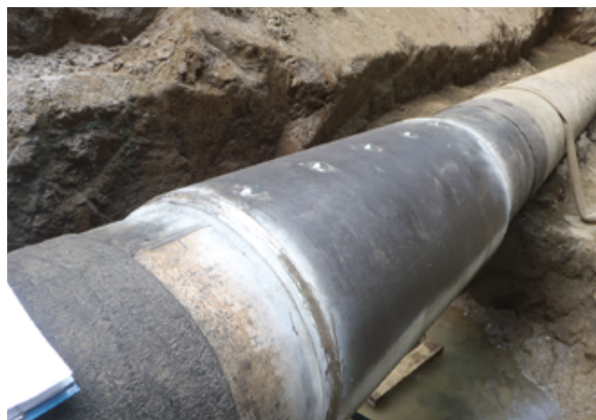
Obr. 2. Potrubí opravené pomocí ocelové objímky Fig. 2 Pipe repair using a steel sleeve
