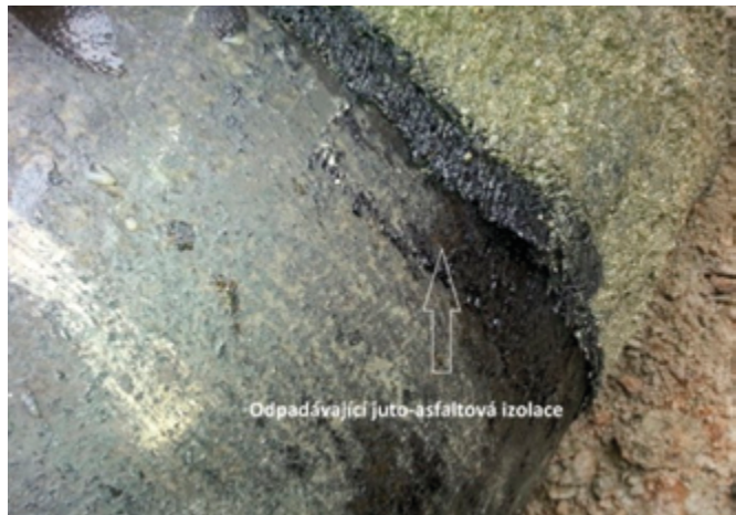
Obr. 4. Nekvalitní juta-asfaltová izolace Fig. 4 Low-quality jute and bitumen coating
