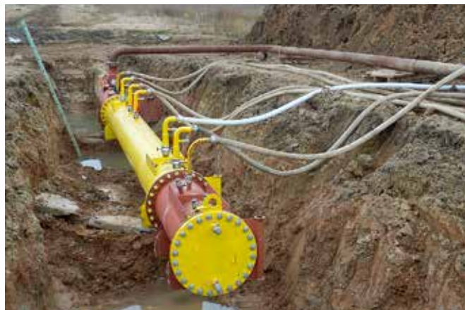
Obr. 7. Napojení sestavy vysílací komory a nástavců na vodovodní potrubí
