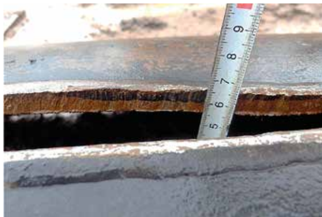
Obr. 10. Stěna potrubí v místě destrukce
