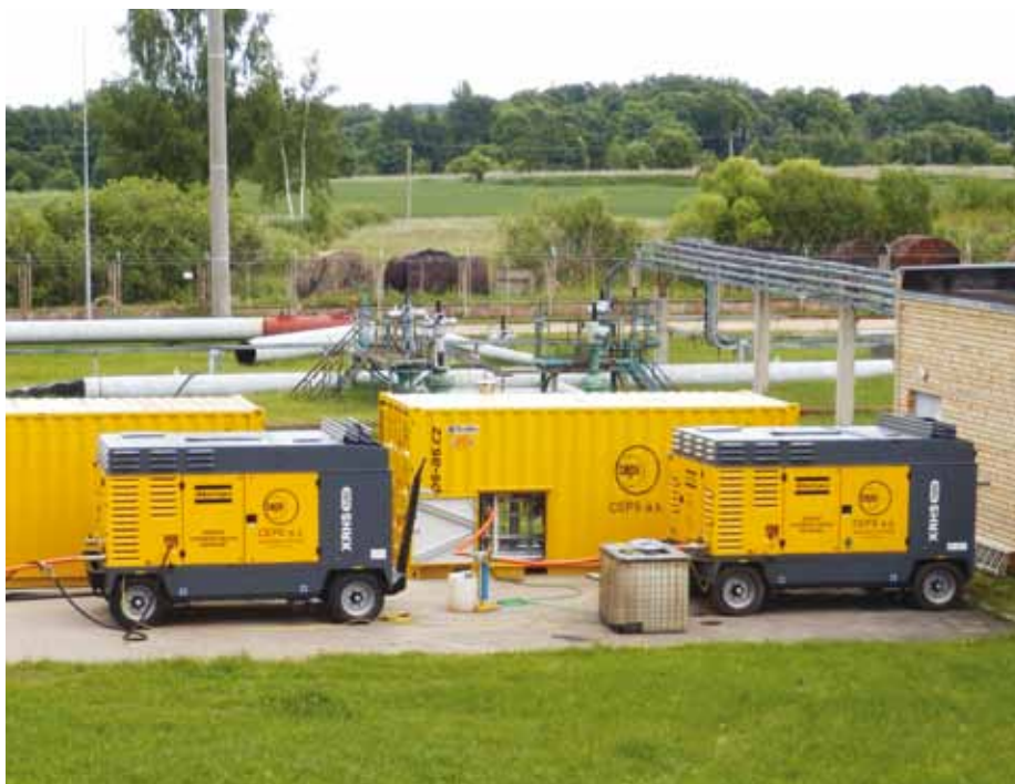
Obr 3: Mobilní Technologický řetězec pro přípravu tlakové plyné směsi pro inertizaci potrubí (2 generátory dusíku a kompresory) OPPI 4.1 IN04/944
