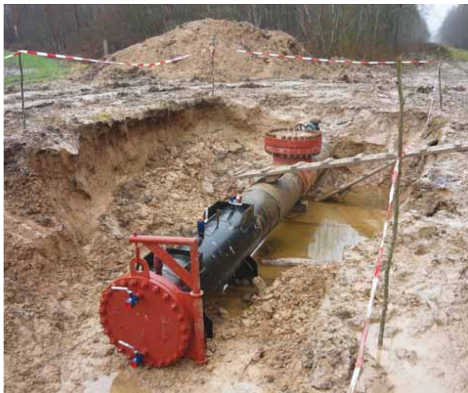
Obr. 2: Dočasná vysílací/přijímací komora CEPS
