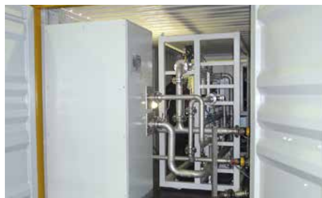
Potrubní rozvody generátoru dusíku jsou dosti komplikované
