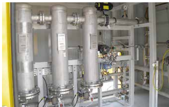
Předehřátý procesní vzduch musí být zbaven v demistrech i nejmenších kapiček kondenzátu
