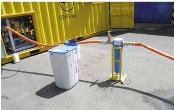
Externí separátor kondenzátu z procesního vzduchu a odlučovač oleje z kondenzátu
