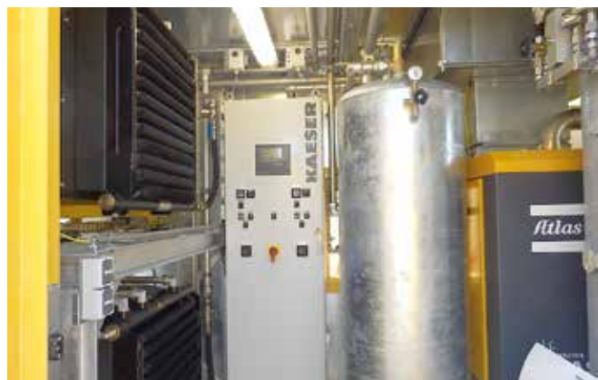
Řídicí jednotka, vzdušníky a elektrocentrála boosterů
