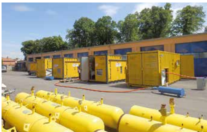
Systémové zkoušky řetězce v CEPS Cítoliby
