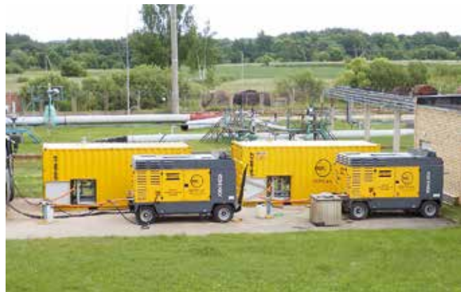
Technologický řetězec na přečerpávací stanici ropovodu v Lotyšsku
