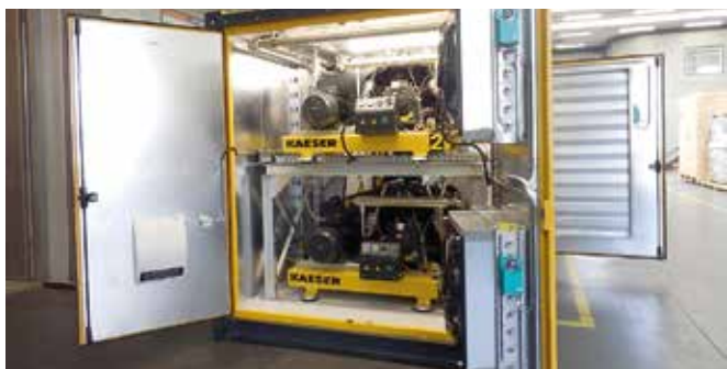
Pohled na boosterovou jednotku (kompresory jsou umístěny nad sebou)
