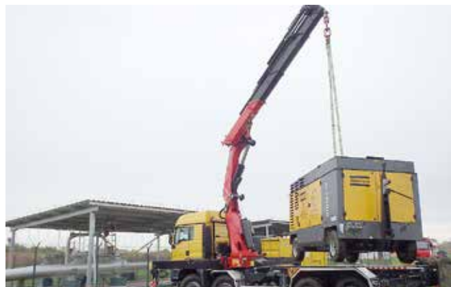
Kompresor procesního vzduchu
