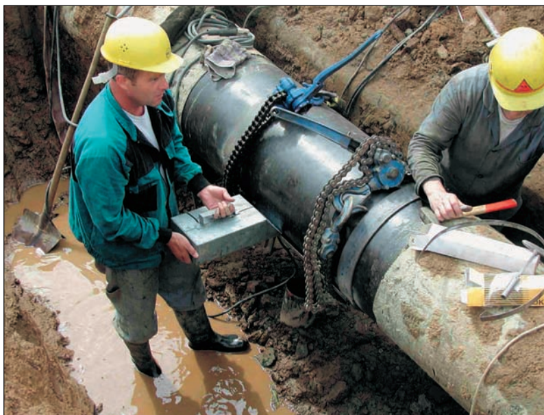
Instalace ocelové objímky
